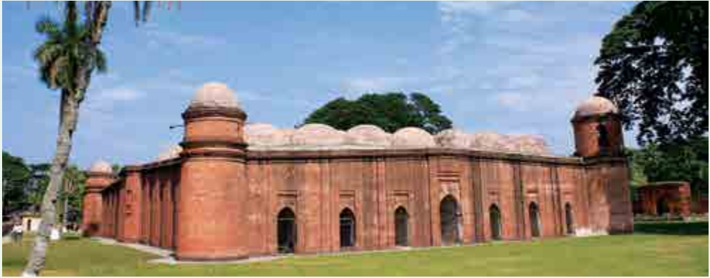
Sixty-Dome Mosque, Bagerhat
