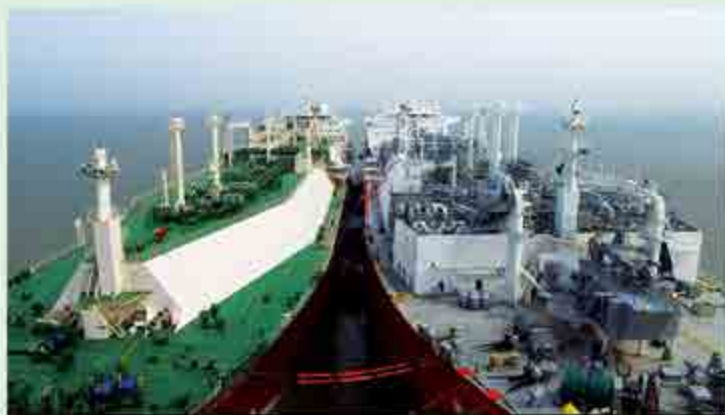
Moheshkhali LNG Terminal
