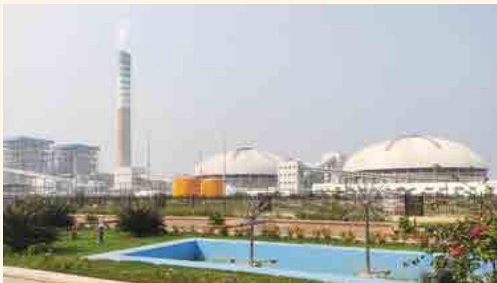
Payra 1320 MW Thermal Power Plant, Patuakhali
